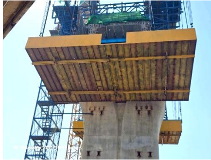
ภาพที่ 2.2-57 การติดตั้ง Steel Sheet ป้องกันวัสดุและของเหลวตกหล่น
