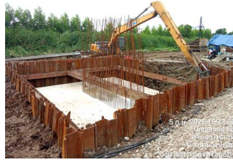
ภาพที่ 2.2-45 การติดตั้ง Sheet Pile
