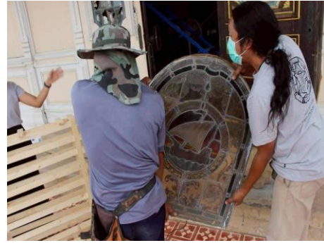
การรื้อถอนและถอดเก็บกระจกสีก่อนการก่อสร้างบริเวณอาคารพลับพลาที่ประทับ (หน่วยงานที่ดำเนินการ: กรมศิลปากร)
